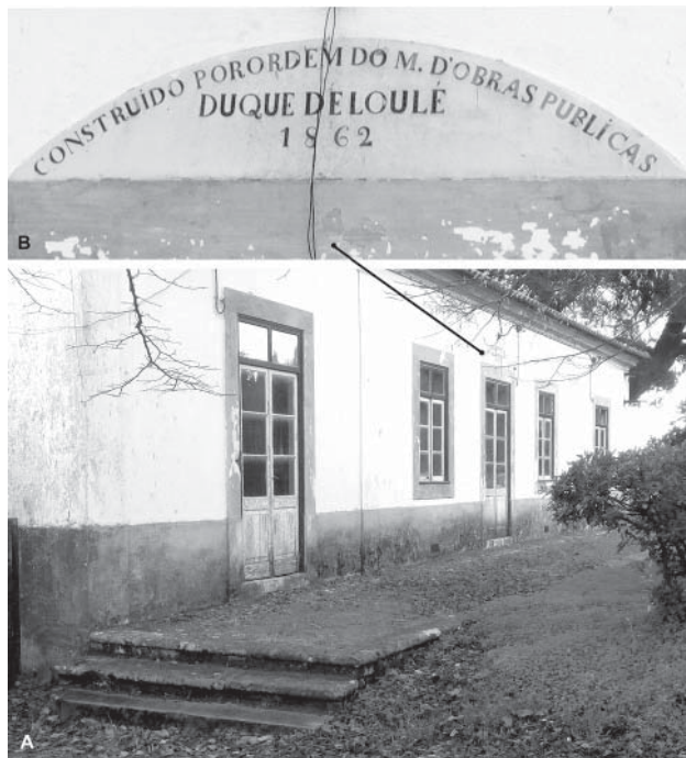
Fig. 7. Cais, edifício (A) e lápide comemorativa (B) da estação de caminho-de-ferro de Pedreanes. O “americano” foi substituído, nos anos 1920, por tração a vapor, mantendo-se em funcionamento até à década de 1960. Fotos dos autores, 2016.
