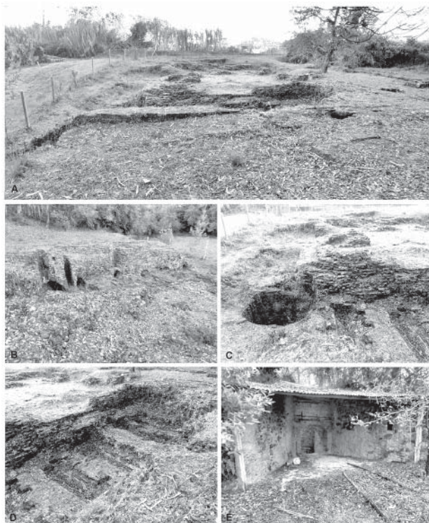
Fig. 9. Ruínas do embasamento da casa das caldeiras, em tijolo burro com argamassa de cimento (A, B C), evidenciando as condutas de circulação de água (D) e o forno de cal (E). Fotografias dos autores, 2016.
