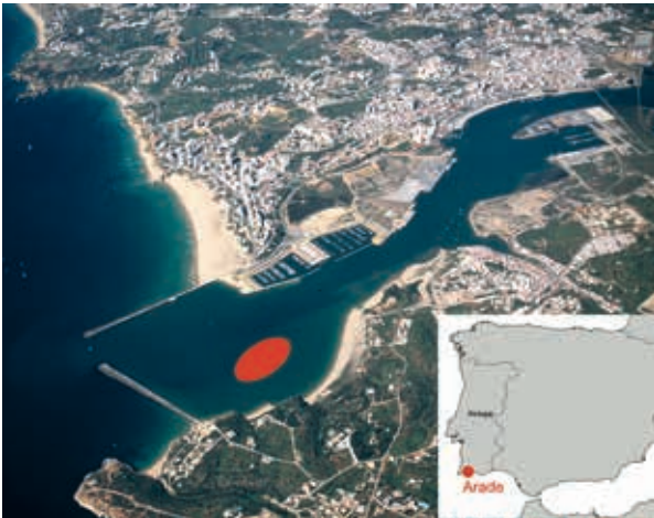
1. Estuário do rio Arade com a implantação de Arade B (foto: Arquivo do Museu de Portimão).
