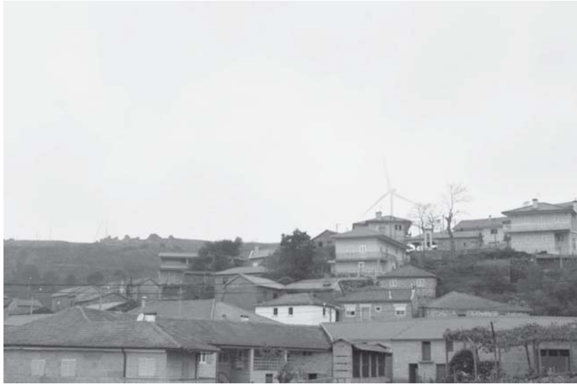
Figura 5.5 – Parque Eólico de Terras Altas de Fafe
