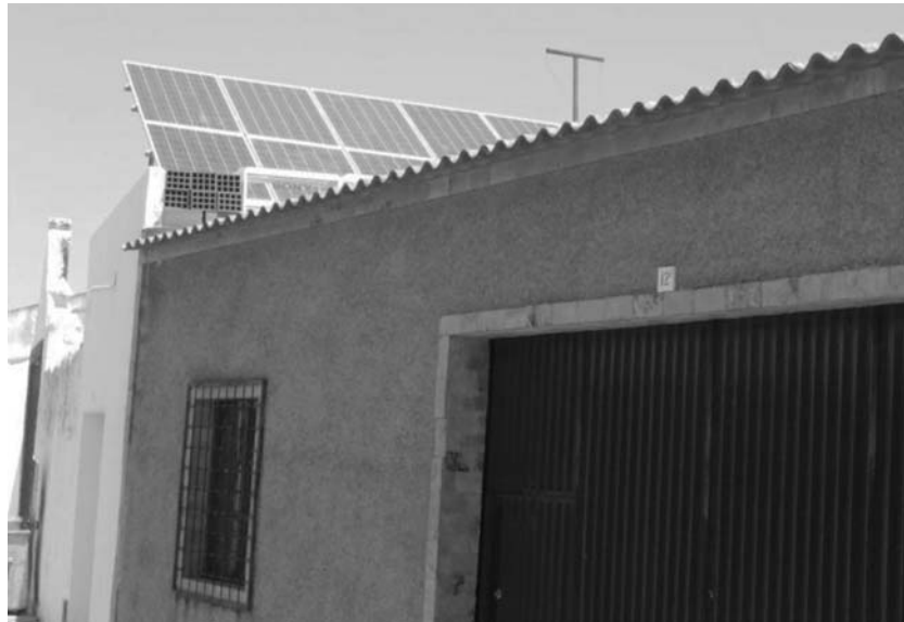
Figura 6.5 – Painel fotovoltaico em casa particular em Amareleja
