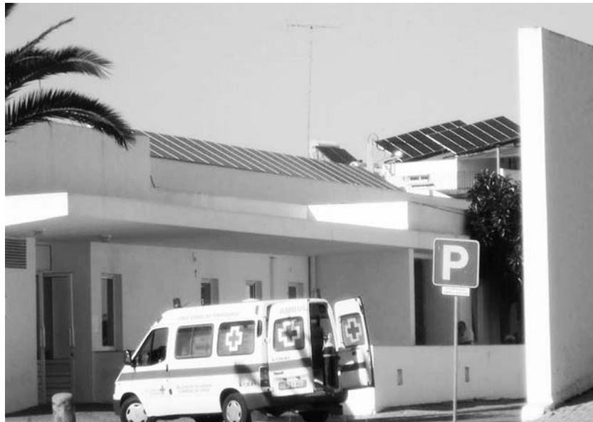
Figura 6.4 – Painel fotovoltaico no Centro de Saúde de Moura
