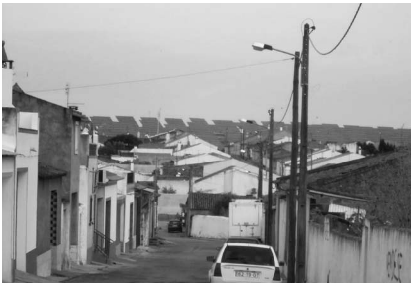
Figura 6.2 – Central Fotovoltaica da Amareleja
