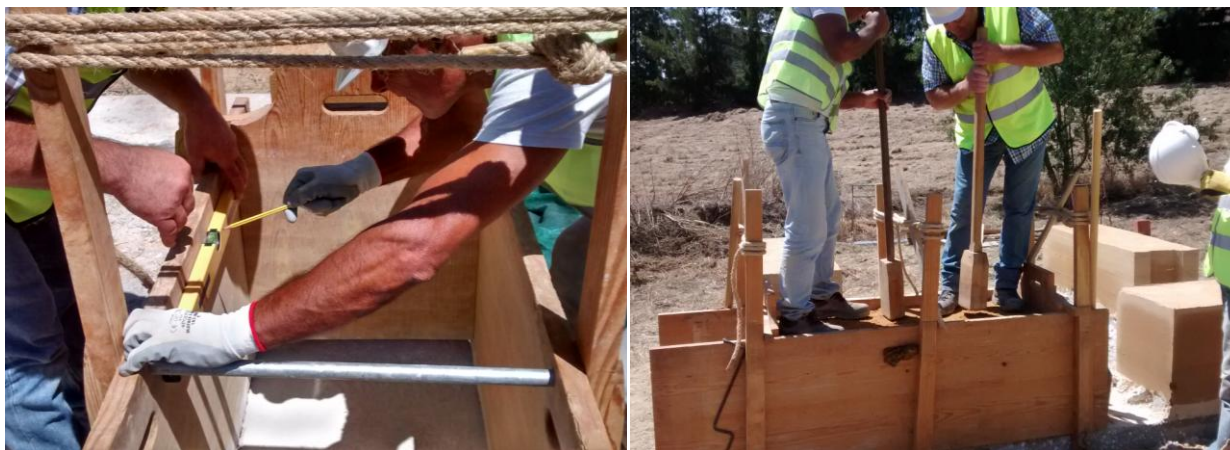
Figura 5. Formandos em avaliação prática da unidade F (cofragens) e Br (construção de taipa).
