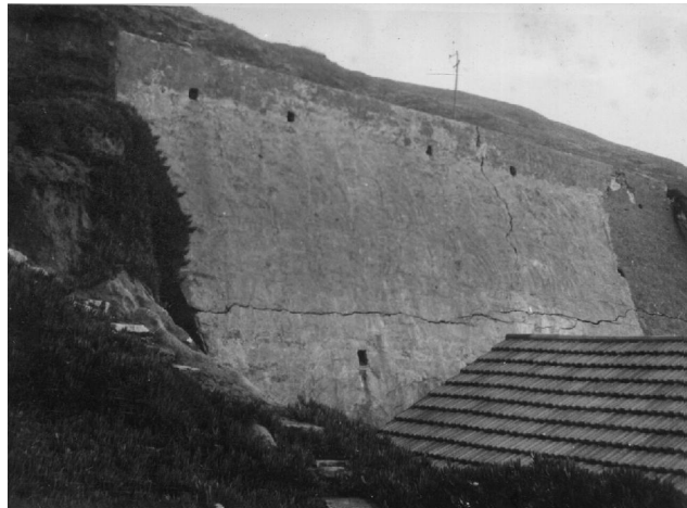
Figura 3. Aspeto da extremidade setentrional do muro de alvenaria construído para sustentação do depósito de vertente contíguo às galerias de serviço da mina do Cabo Mondego e à casa de escolha do carvão. Foto de E. Fleury, efetuada aquando da visita de inspeção que efetuou às instalações, em 1937. Fonte: Fleury, 1941. Col. J.S. Pinto.
