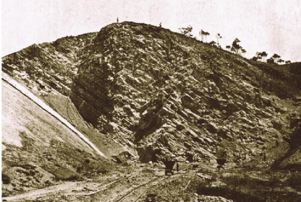
Figura 2. Panorâmica da “pedreira da cal” contígua à mina do Cabo Mondego, evidenciando os estratos oxfordianos de fácies lacustre, com acentuado pendor para sul. Fotografia: autor desconhecido, ca. de 1920. Col. J.S. Pinto.
