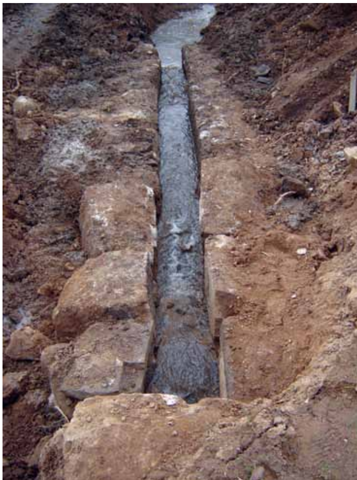
Fig. 8 – Estrutura 26 localizada na Estrada da Guerreira.
