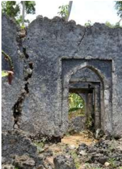
Ruína de Mvuleni. Fotografia da autora.
