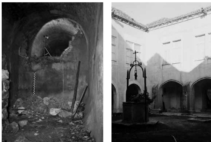
Figuras V e VI - Desmantelamento da antiga cisterna construída na galeria norte do criptoportico romano e respectivo poço exterior erguido no segundo pátio. Data: Década de 1930.
