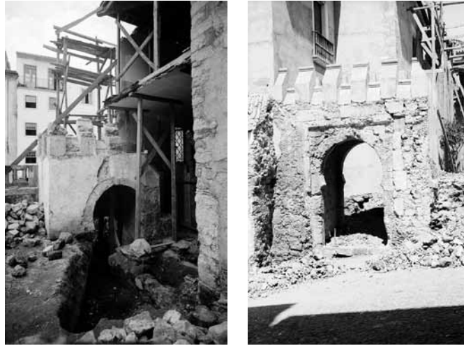
Figuras III e IV - Obras de desentulhamento e reconstrução do arco de dupla face no sector sudeste do antigo paço episcopal de Coimbra. Data: Década de 1920
