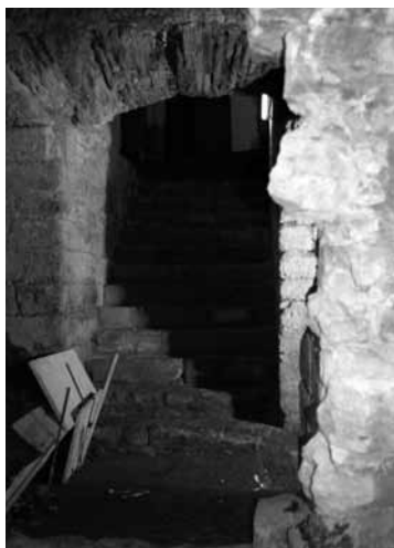
Figura VII - Escadaria aberta nas estruturas romanas do criptopórtico para permitir o acesso ao pomar/logradouro.
