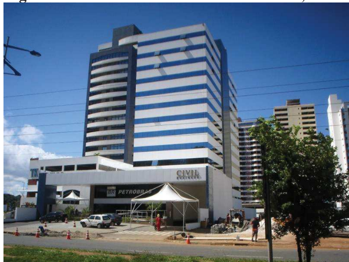
Figura 6: Prédio sede do COFIP – Salvador, Bahia.
