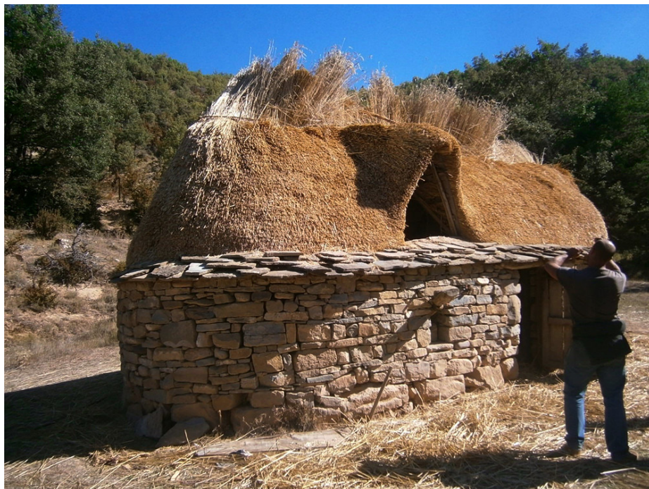
Fig. 2. Construção de telhado de palha na granja de Santi.
