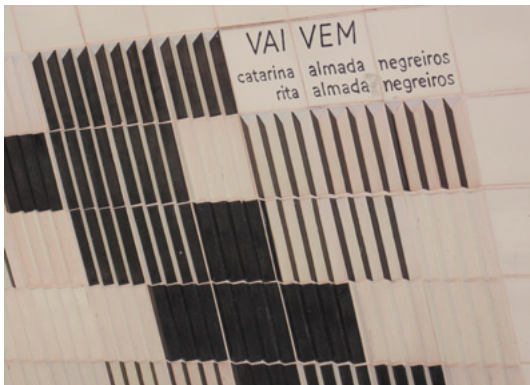
Pormenor da assinatura da obra, verificando-se a alternância entre azulejos lisos e relevados. Fotografia da autora (2015).
