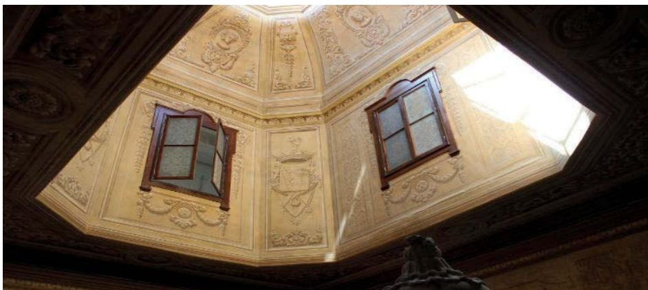
Fig. 9 – Vista parcial da pintura mural da escadaria. Foto DR.
