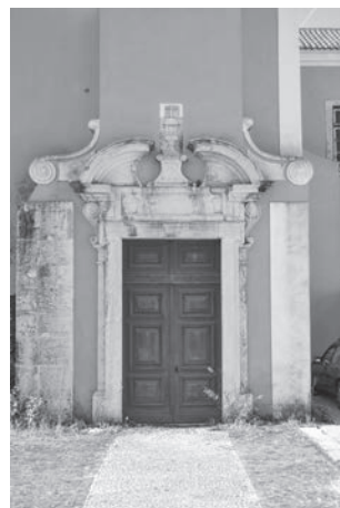
Fig. 3. Portal da antiga igreja do convento do Santíssimo Sacramento de Alcântara. Fotografia da autora.
