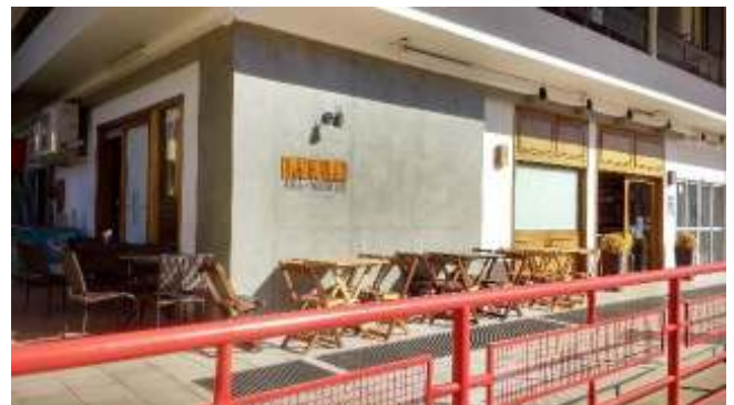
Foto 5 – Vista de bloco de construção mais recente na Quadra CLN 412/413
